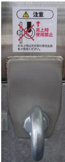
水槽側面の吊りボルトは、吊上げ用途には使用しないで下さい。
