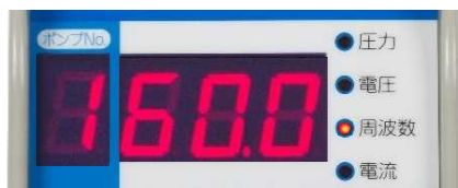
運転周波数表示 (例: 1号ポンプ 60Hz)
